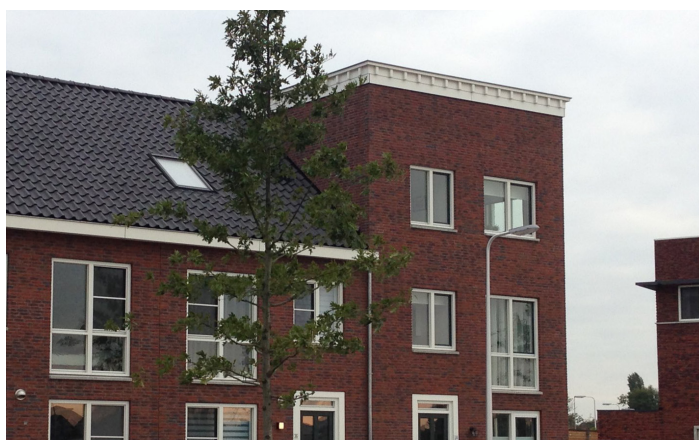
▷ Boekensteun met plat dak
