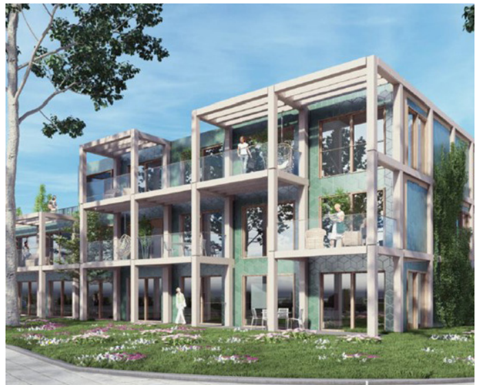
▷ Balkons worden afgehangen in voor de gevel geplaatste pergolaconstructie
