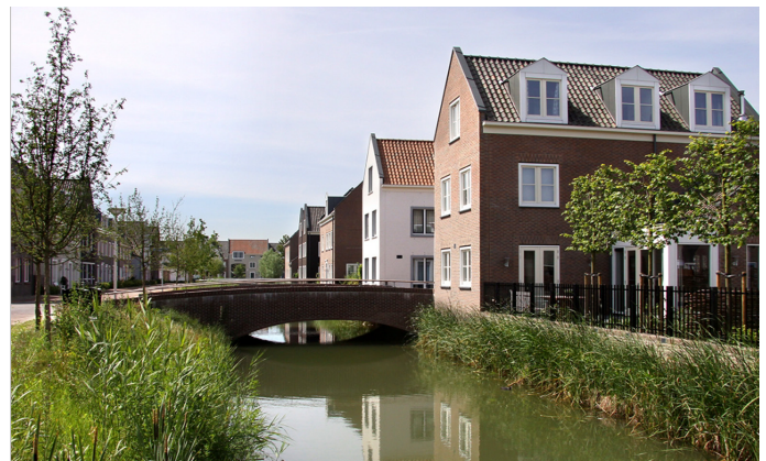
▷ Woningen staan met de voeten in het water. De erfafscheiding is integraal mee ontworpen
