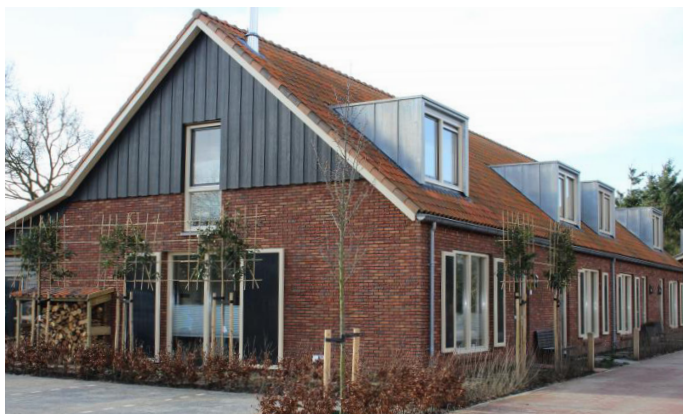
▷ Gepotdekselde gevels en rood-bruin metselwerk
