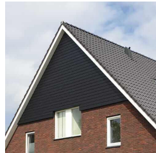
▷ Beschietting van topgevel
