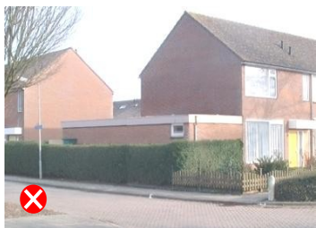
zijaanbouw te dicht bij voorgevelrooilijn
