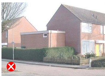
zijaanbouw te hoog
