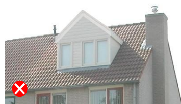
vormgeving sluit niet aan op stijl van woning
